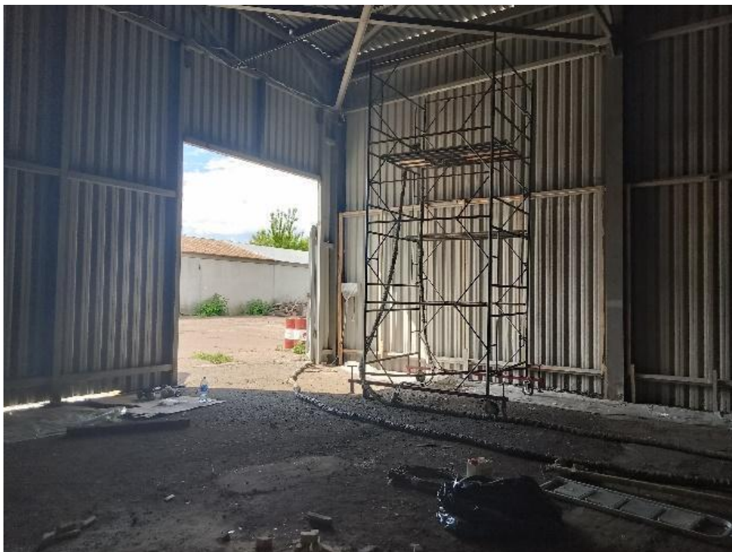
Рисунок 1. Вид объекта изнутри, зона главного входа
