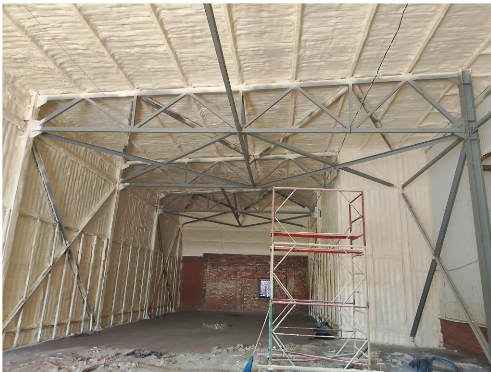
Фото объекта после выполнения работ
