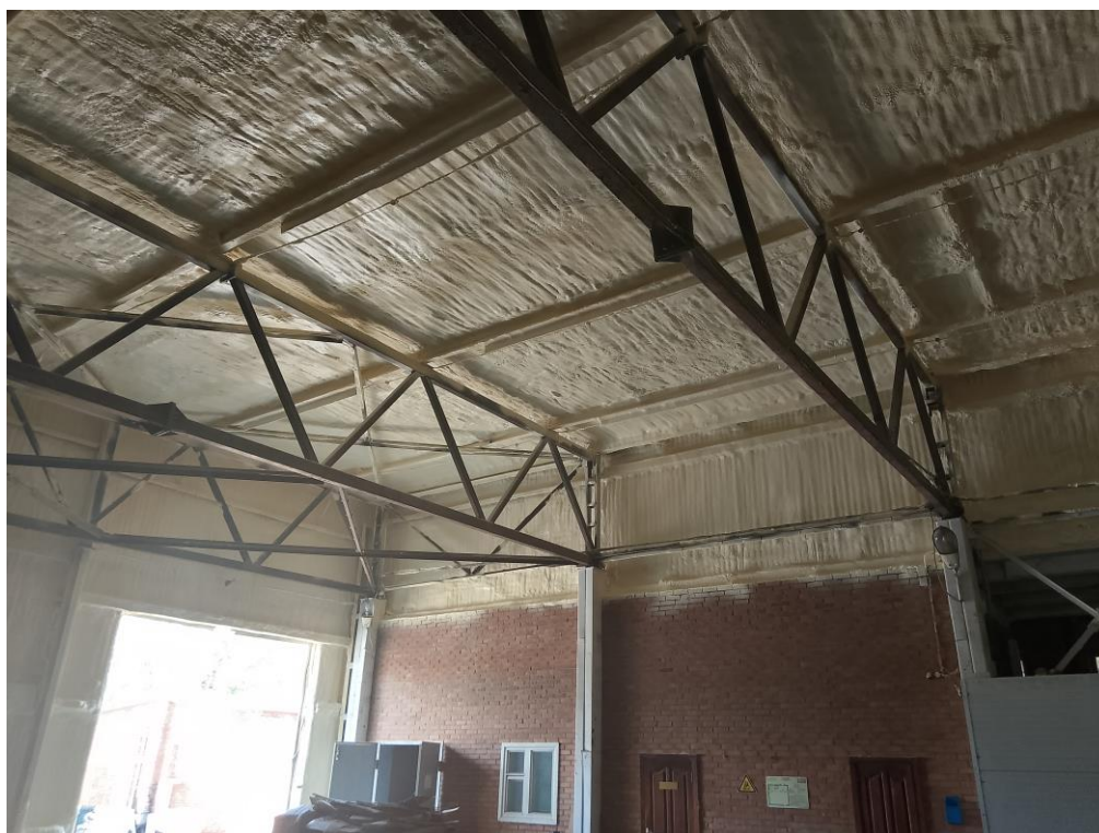
Фото объекта после выполнения работ (главный вход)
