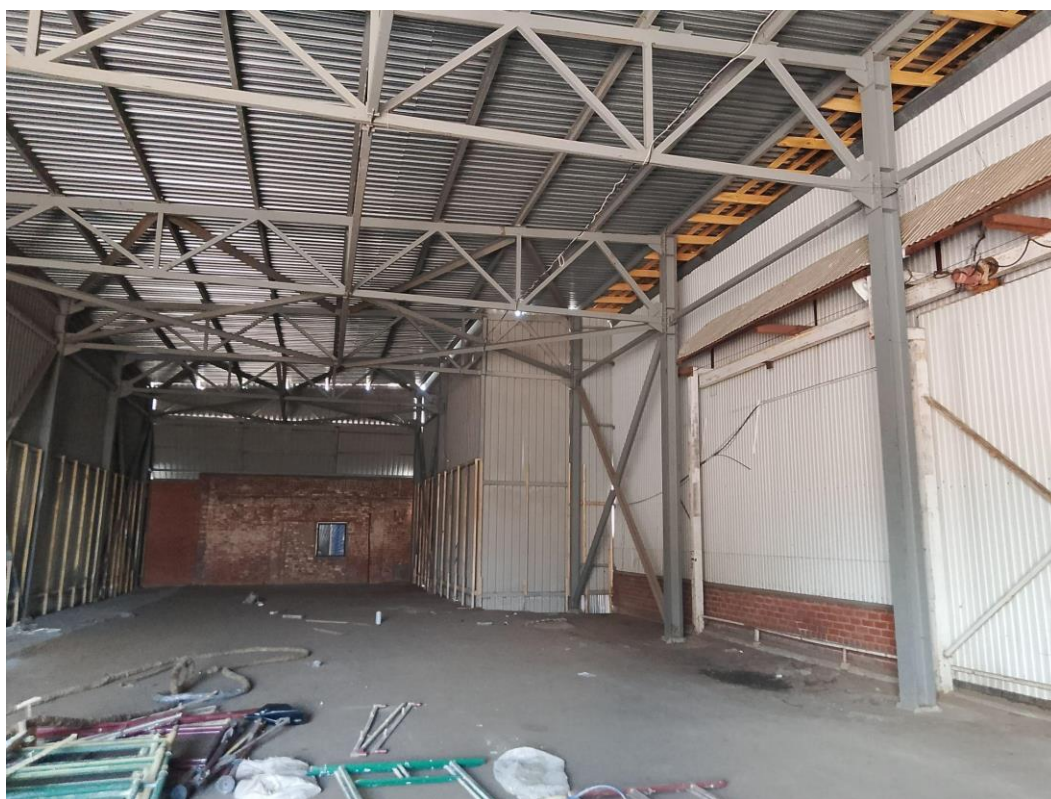
Рисунок 2. Потолок из металлопрофиля; стены частично из металлопрофиля и кирпича
